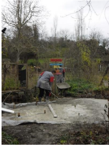
Construction d'une terrasse en atelier travaux d'extérieur novembre 2020.
